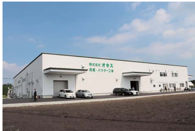
完成したオキスの新工場
