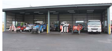
新しくできた農業用機械の格納庫
