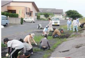
垂水(支所裏護岸まわり)
